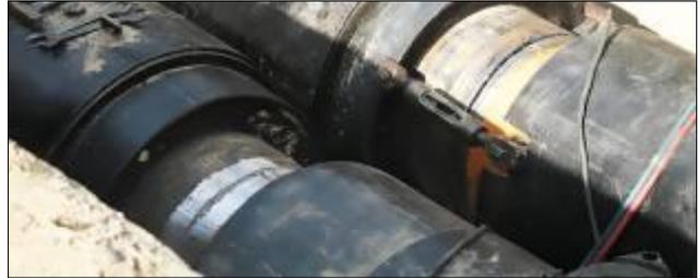
6.5.13.13 При выполнении сварочных работ необходимо обеспечить защиту поверхностей сильфонов СК и SKU и их изоляции от попадания брызг расплавленного металла, сварного грата и окалины.
