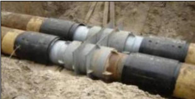
неизолированным концом трубопровода ППМ-смеси через передвижную инвентарную опалубку, закрепленную стяжными ремнями на ППМ-изоляцию трубопровода и стальную гильзу SKU.
