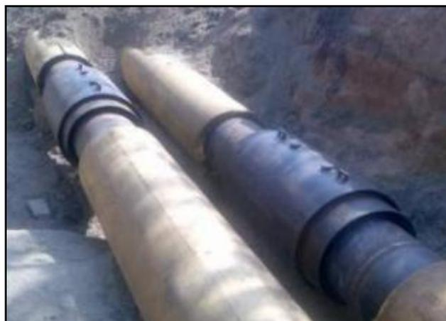
кожуха нанесено антикоррозионное гидрозащитное покрытие. Для снижения тепловых потерь между сильфоном и цилиндрической направляющей проложен теплоизоляционный материал.
