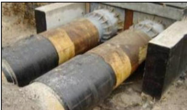
пенополимерминеральной тепловой изоляцией с максимальной температурой теплоносителя до 150 °С при всех способах их прокладки, в т.ч. и бесканальной. СКУ типа ППМ также могут применяться при ремонтах и новом строительстве стальных трубопроводов с индустриальной теплоизоляцией из автоклавного армопенобетона.
