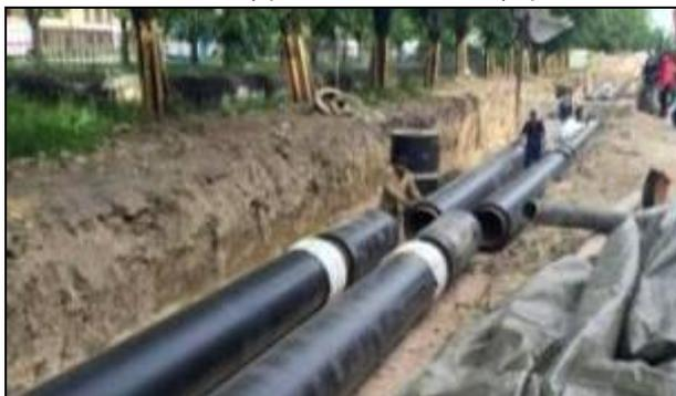
для компенсации осевых температурных деформаций стальных трубопроводов с индустриальной теплоизоляцией из пенополиуретана в полиэтиленовой оболочке.
