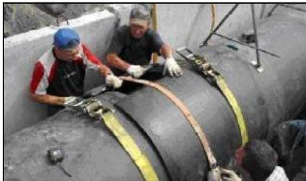
Для изоляции стыков SKU с трубопроводом в пенополиуретановой теплоизоляции со стальной защитной оболочкой необходимо выполнить установку разъемного кожуха-муфты из тонколистовой оцинкованной стали и заливку стыков SKU с трубопроводом пенополиуретаном.
