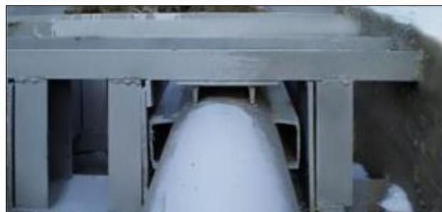
5.5.14 В общем случае максимальная боковая нагрузка на направляющую опору составляет 15% от распорного усилия компенсатора (см. п. 5.83 и 5.84, а также таблицу 9 настоящего РД). Детали направляющей опоры должны быть рассчитаны на боковую нагрузку, исходя из необходимости полной соосности трубопровода и СК при возможном изломе трубопровода до 5 градусов.
