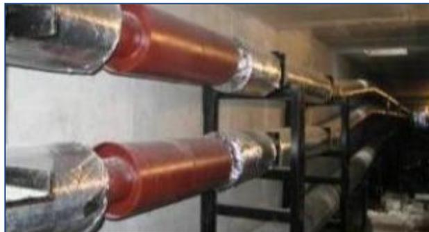
опорный фланец. Ограничитель сверхдопустимых растяжений сильфона представляют собой кольцо, приваренное изнутри к торцу кожуха, в которое цилиндрическая направляющая упрется при достижении сильфоном максимально допустимого значения растяжения, предохранив сильфон от сверхдопустимого сжатия при возникновении штатных ситуаций на трубопроводе.
