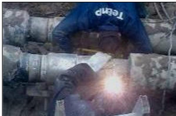
чем, если бы трубопровод был смонтирован без ССК. Таким образом, ССК срабатывают один раз и после заварки кожухов становятся неподвижной частью трубопровода.
